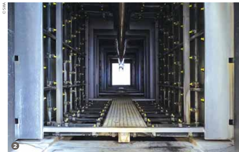
Figura 2: Il tunnel di pretrattamento installato presso SMA doo Vršac.
